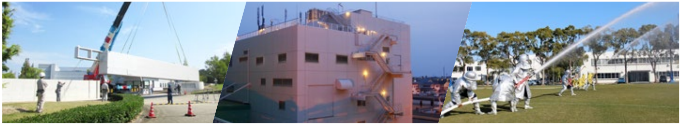
大塚製薬工場：松茂工場の外周防潮堤の設置
