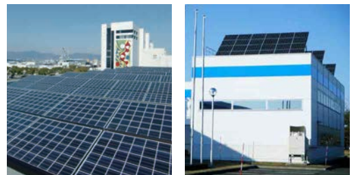
大塚倉庫：今切5号倉庫
