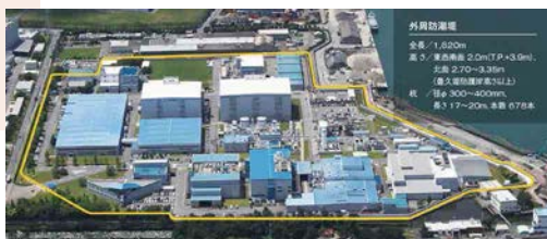
大塚製薬工場：津波対策として外周防潮堤を設置
