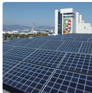
大塚倉庫 今切5号倉庫
