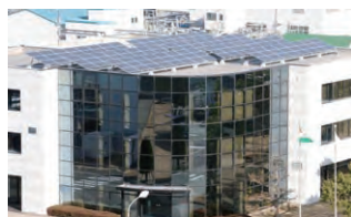
大塚化学徳島工場事務所棟
