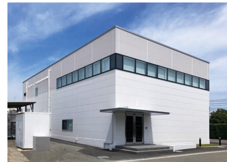
大塚グループエネルギー管理棟
