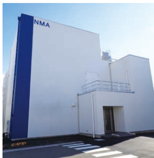
横河電機（株）との合併会社であるシンクレスト（株）（中分子医薬品原薬製造工場）
