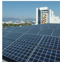
大塚倉庫：今切 5 号倉庫
