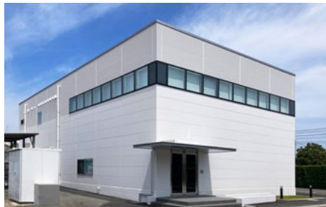
大塚グループエネルギー管理棟
