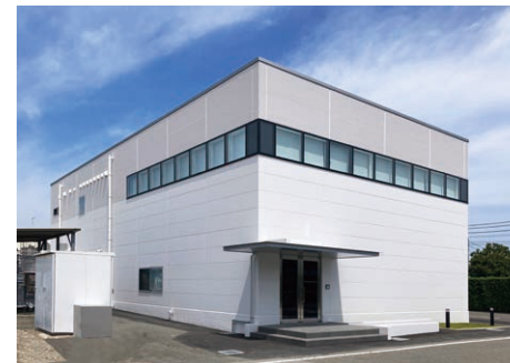
大塚グループエネルギー管理棟
