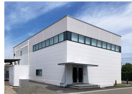
大塚グループエネルギー管理棟
